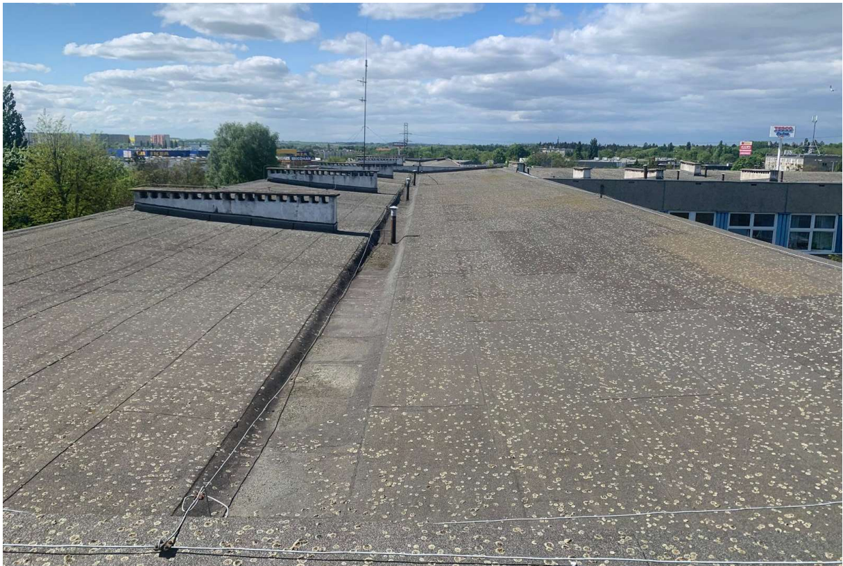
Fot. 9. (Papa wierzchnia z wykwitami mchu)
