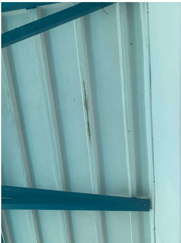
Fot. 24. (Zaciek z dachu nad basenem)
