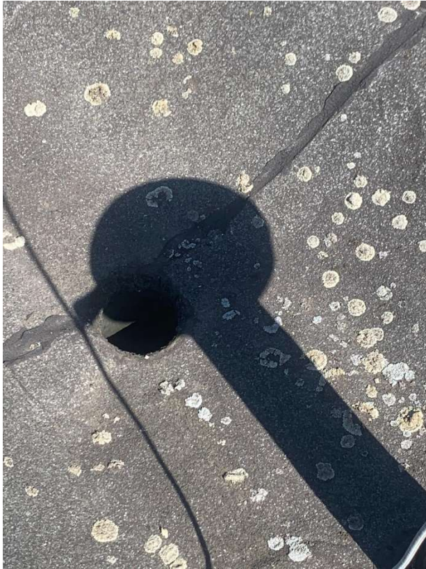
Fot. 21. (Brakująca kratka wpustu dachowego)
