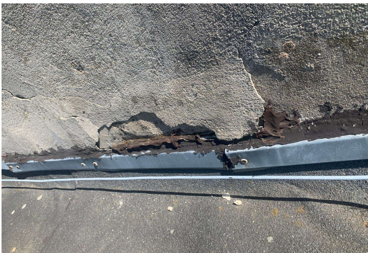
Fot. 17. (Odspojenia tynku, zarysowania i próby naprawy ściany ppoż. )
