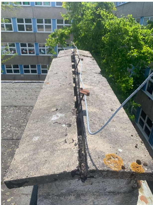
Fot. 16. (Pęknięcie i odspojenie czapy komina)
