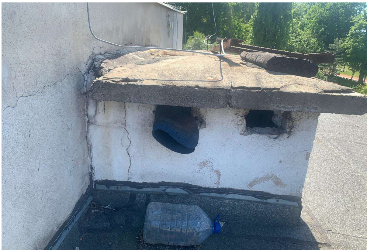
Fot. 14. (Zarysowania powierzchniowe na kominie)
