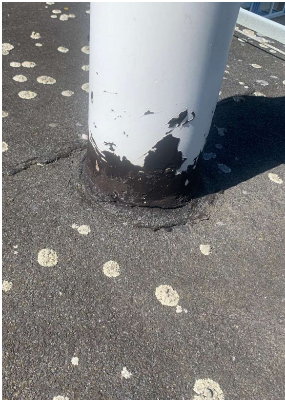
Fot. 10. (Nieszczelne styki papy z kominem wentylacyjnym i papy ze stopą dachową)
