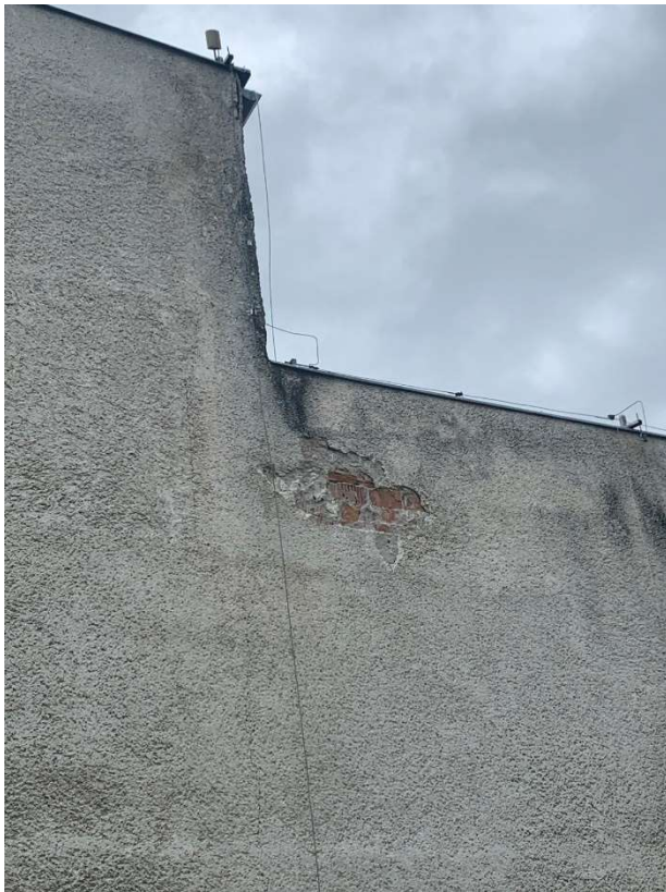
Fot. 5. (Odspojenia tynku i przebarwienia związane z nieszczelnościami dachu)
