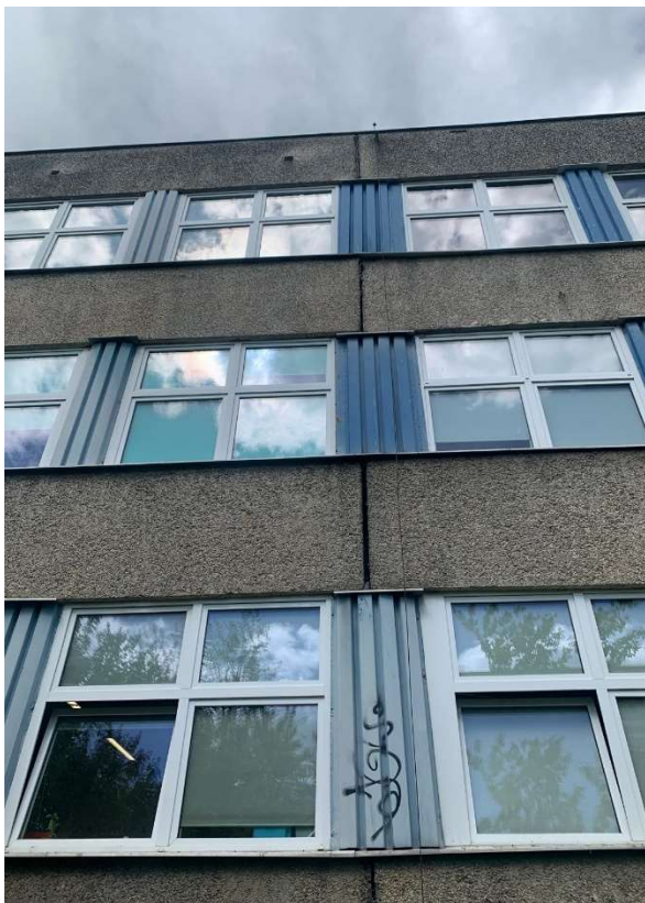
Fot. 2. (Miejsca dylatacji budynku)
