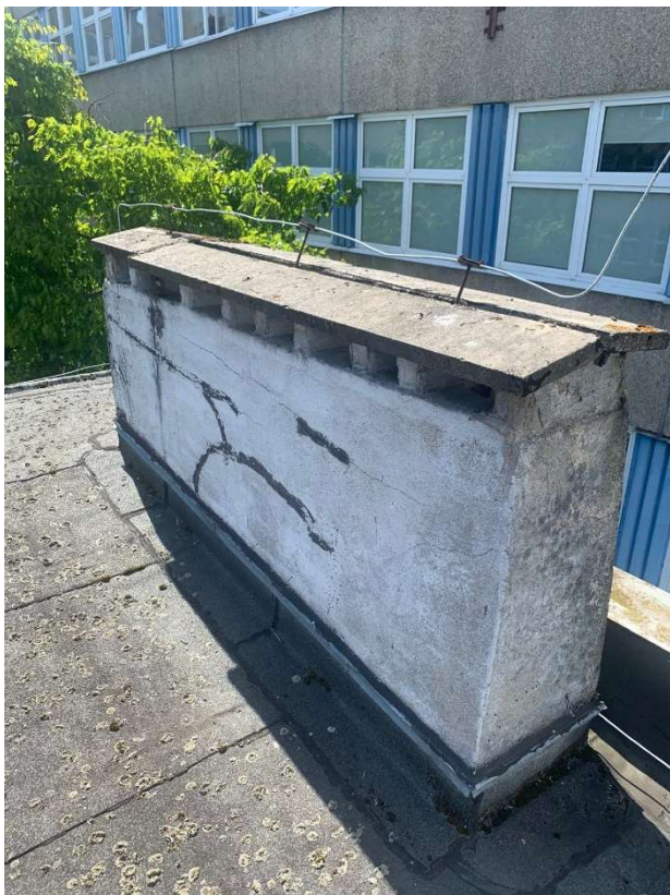
Fot. 15. (Naprawiane zarysowania)
