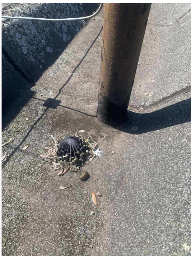
Fot. 20. (Częściowo niedrożne wpusty dachowe))
