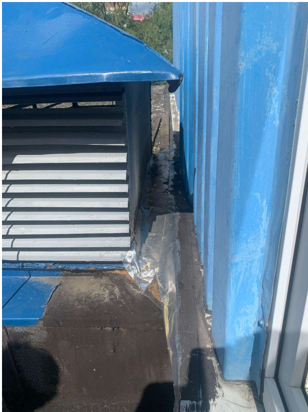
Fot. 23. (Lokalizacja nieuszczelności odpowiadającej za zacieki na ścianie w kuchni)
