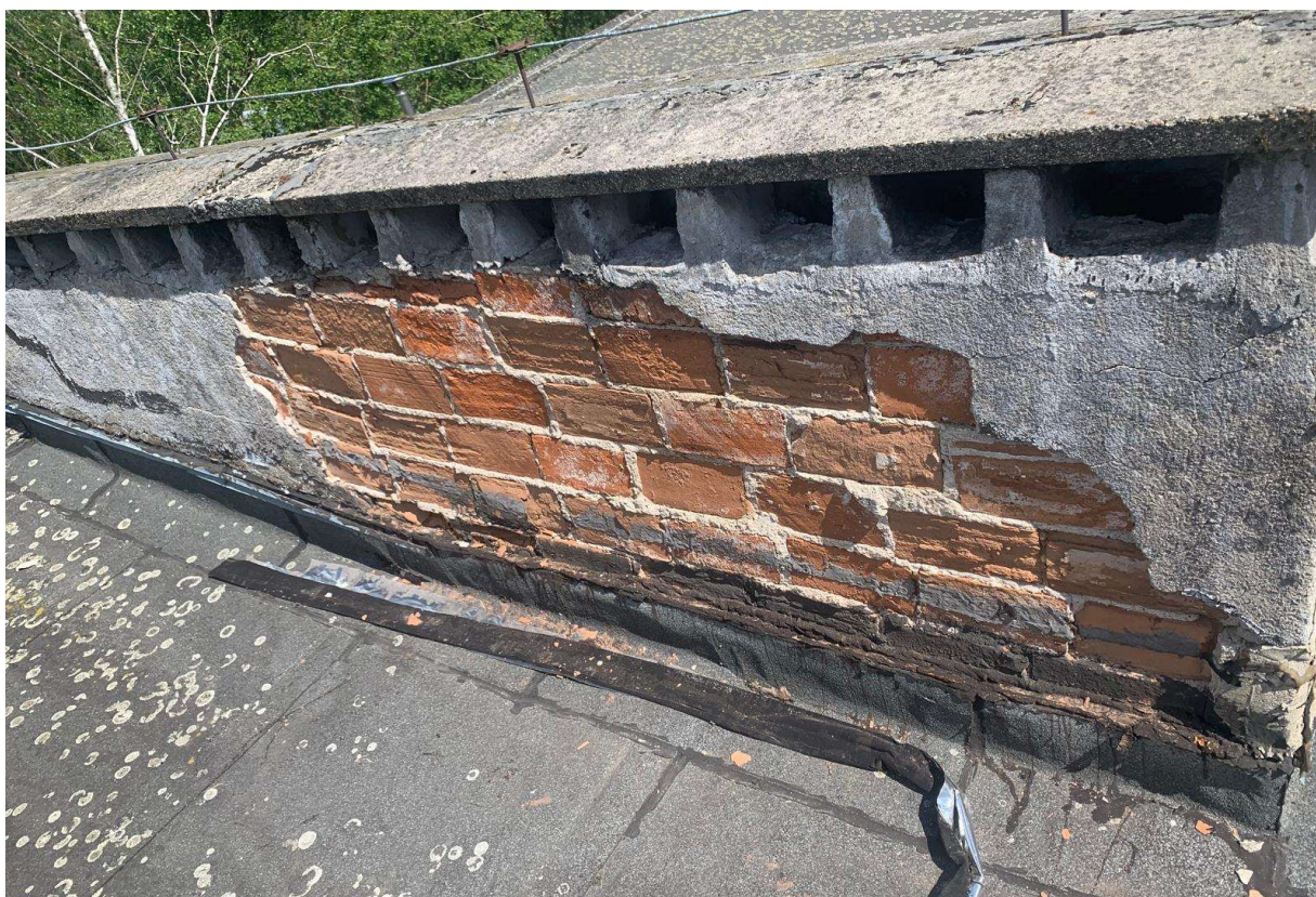
Fot. 12. (Odspojenia i ubytki tynku na kominie)
