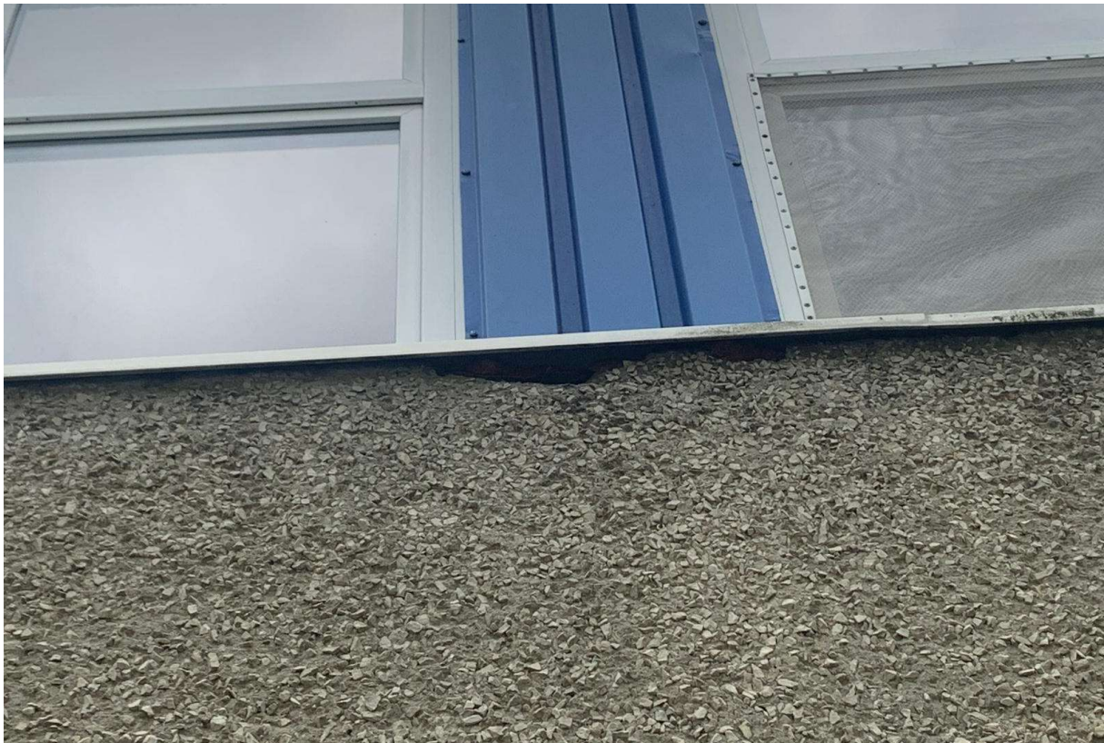
Fot. 1. (Ubytek płyty fakturowej przy obróbce blacharskiej)
