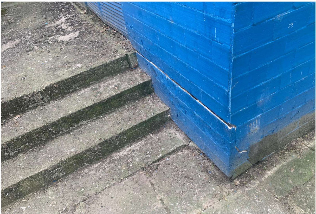
Fot. 6. (Odspojenia płytek cokołu)
