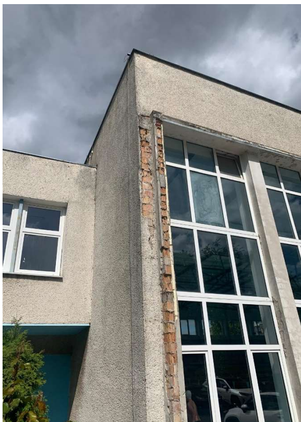
Fot. 7. (Odspojenia i ubytki tynku, łuszczenie się farby)
