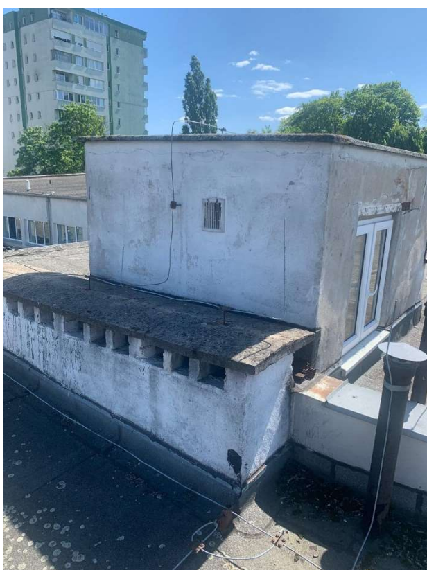
Fot. 18. (Zarysowana powierzchniowo nadbudówka )
