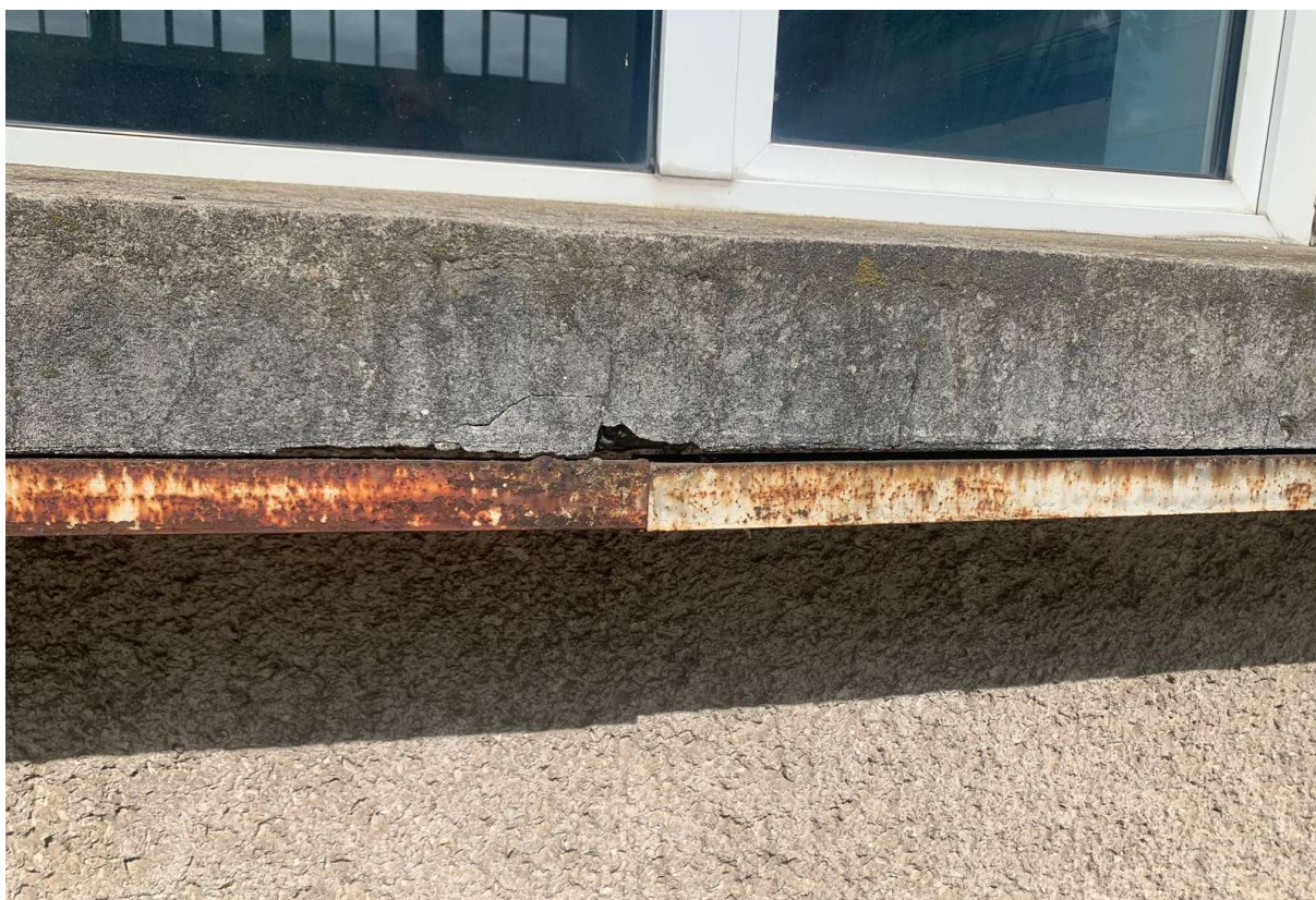
Fot. 8. (Brak parapetu; zardzewiały ceownik pod gzymsem)
