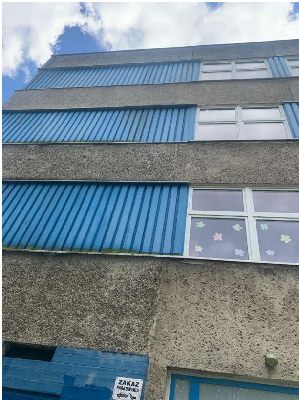
Fot. 3. (Wykwity na okładzinowej blasze trapezowej)
