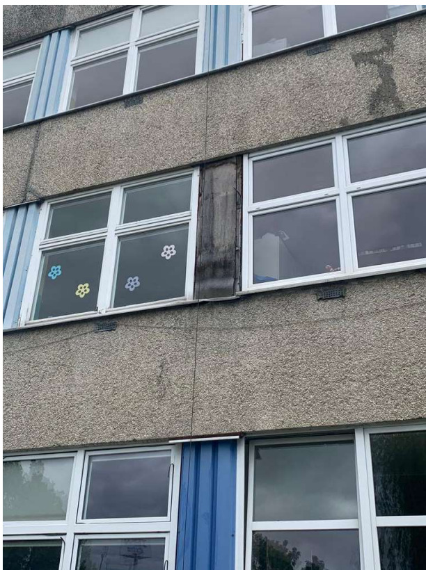
Fot. 4. (Brakująca okładzina)
