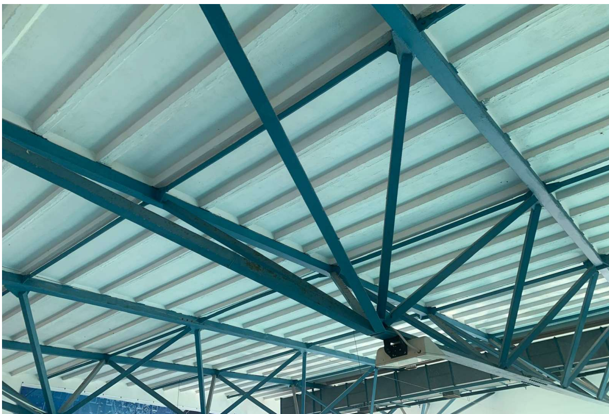
Fot. 25. (Miejscowa korozja kratownic nad basenem)
