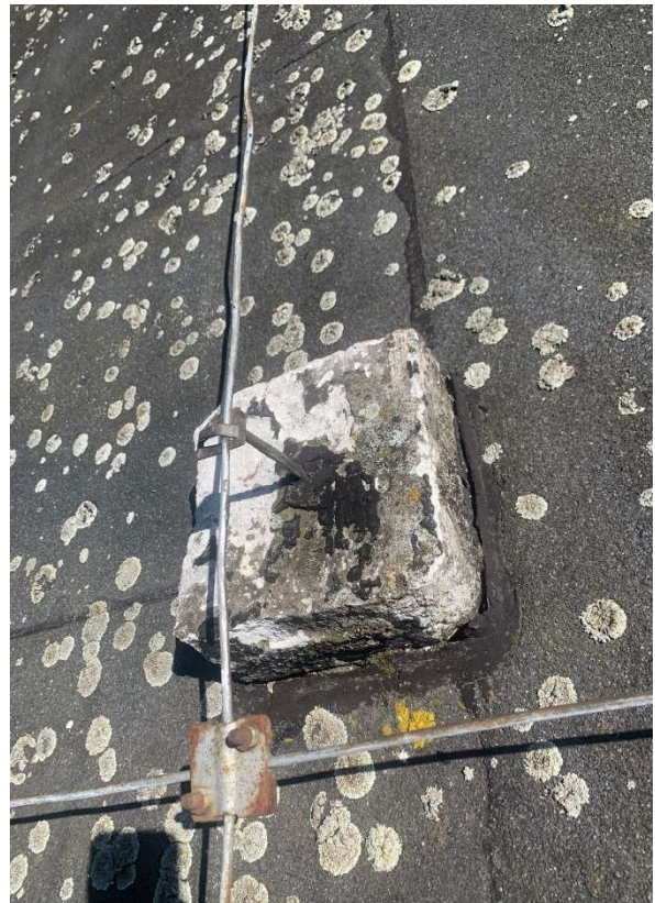
Fot. 10. (Nieszczelne styki papy z kominem wentylacyjnym i papy ze stopą dachową)
